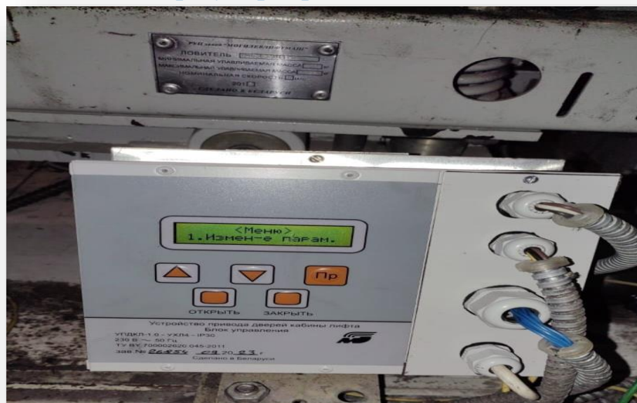
Замена устройства привода дверей кабины по адресу: пр. Гражданский д.73
