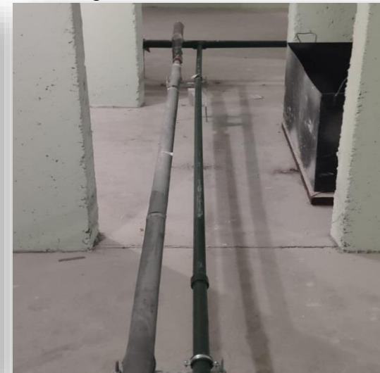
Замена внутридомовых инженерных систем на чердаке (ХВС)
