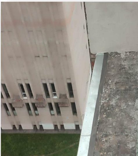
Гидроизоляция балконного козырька А. Константинова, д. 4 корп. 1
