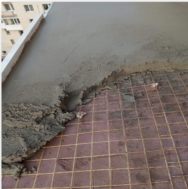
Ремонт козырька балкона: ул. Обручевых д.8 корп.1
