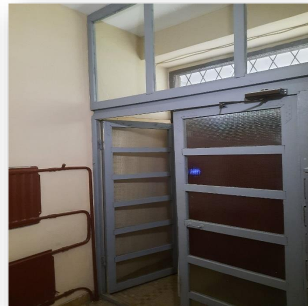
Замена тамбурных дверей: пр. Гражданский д.19 корп.2
