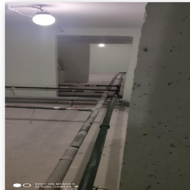
Замена внутридомовых систем на чердаке: ул. Бутлерова д.11 к.1
