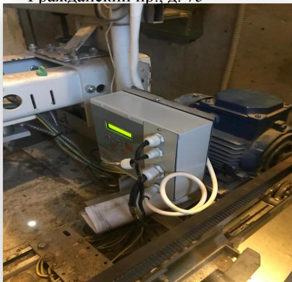
Замена блока дверей кабины лифта Гражданский пр., д. 75
